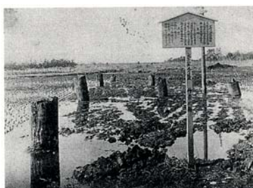
関東大震災で露出した橋脚
