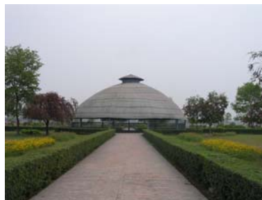
保存のため屋根で覆われている
