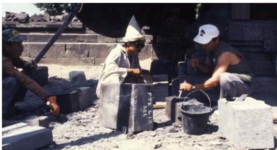
復旧石材加工作業させてもらう右筆者(石張1級)
