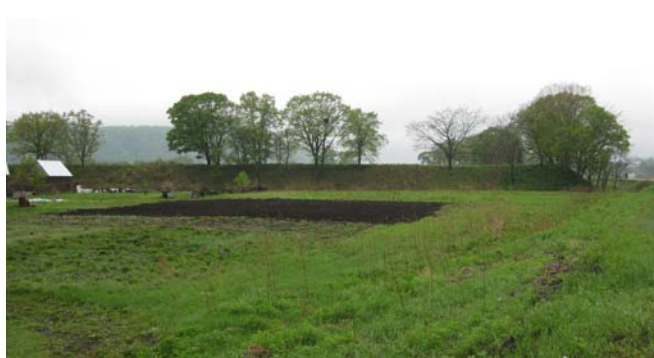
遺跡の外側から見た土塁
