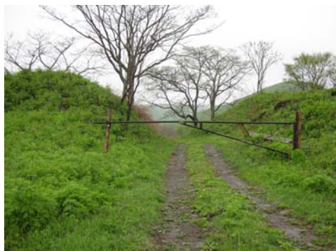
ボハイ遺跡入口・土塀の高さ3、5m位
