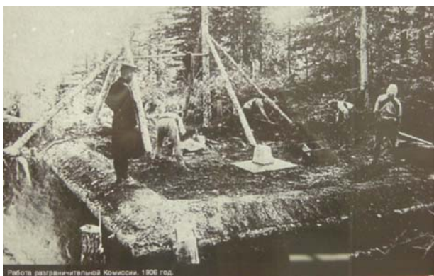
日本軍による樺太境界設工事写真・明治39年(1906)
